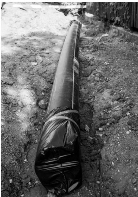
A vezeték solymári szakasza 1813 méter hosszú, 250 mm átmérőjű KPE csővekből áll.
