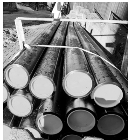
Fektetésre váró vízcsövek
