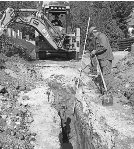
Épül a kerekhegyi csatorna Fotó: Hegedűs András
