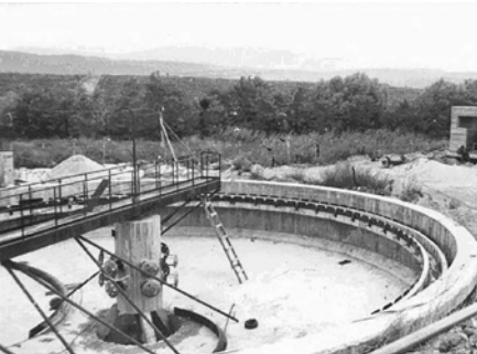
Épülő szennyvíztisztító telep 1979-ben
