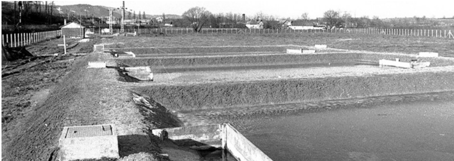
Ideiglenes tisztítómedence a szennyvíztelepen
