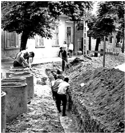
A tanács által csatornaépítéssel megbízott kubikosbrigád a szennyvízcsatornák lefektetését követően a nyílt árkos csapadékvíz-elvezetés pótlására csapadékcatornát fektetett le a Templom téren és több utcában
