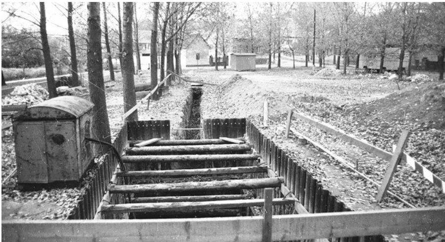
Útátfúrás előkészítése a mai Széchenyi téren a 70-es években
